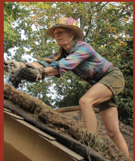
> Het dak wordt met aarde afgedekt.
