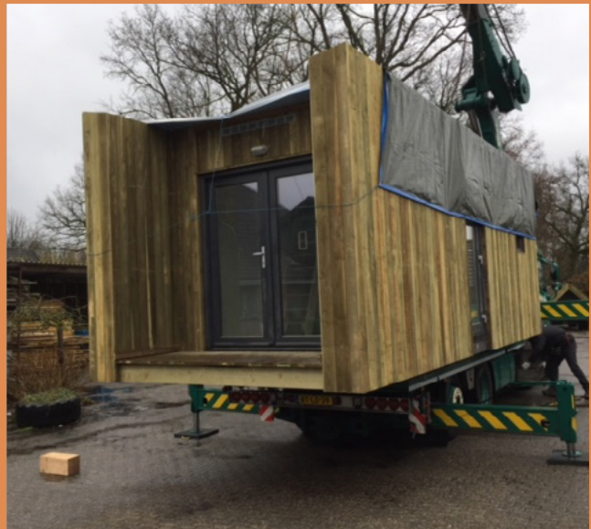
> Vanuit de timmerwerkplaats ging het huisje op een dieplader.
