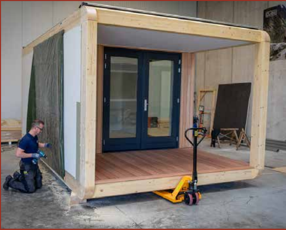
> Eerst folie aanbrengen aan de open zijdes.
