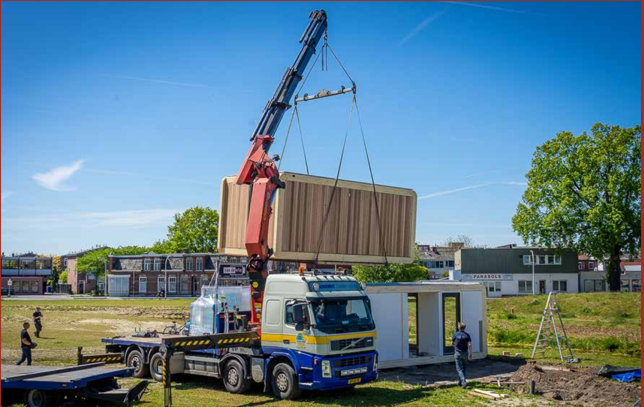
> De tweede Cube wordt naast de eerste gehesen.
