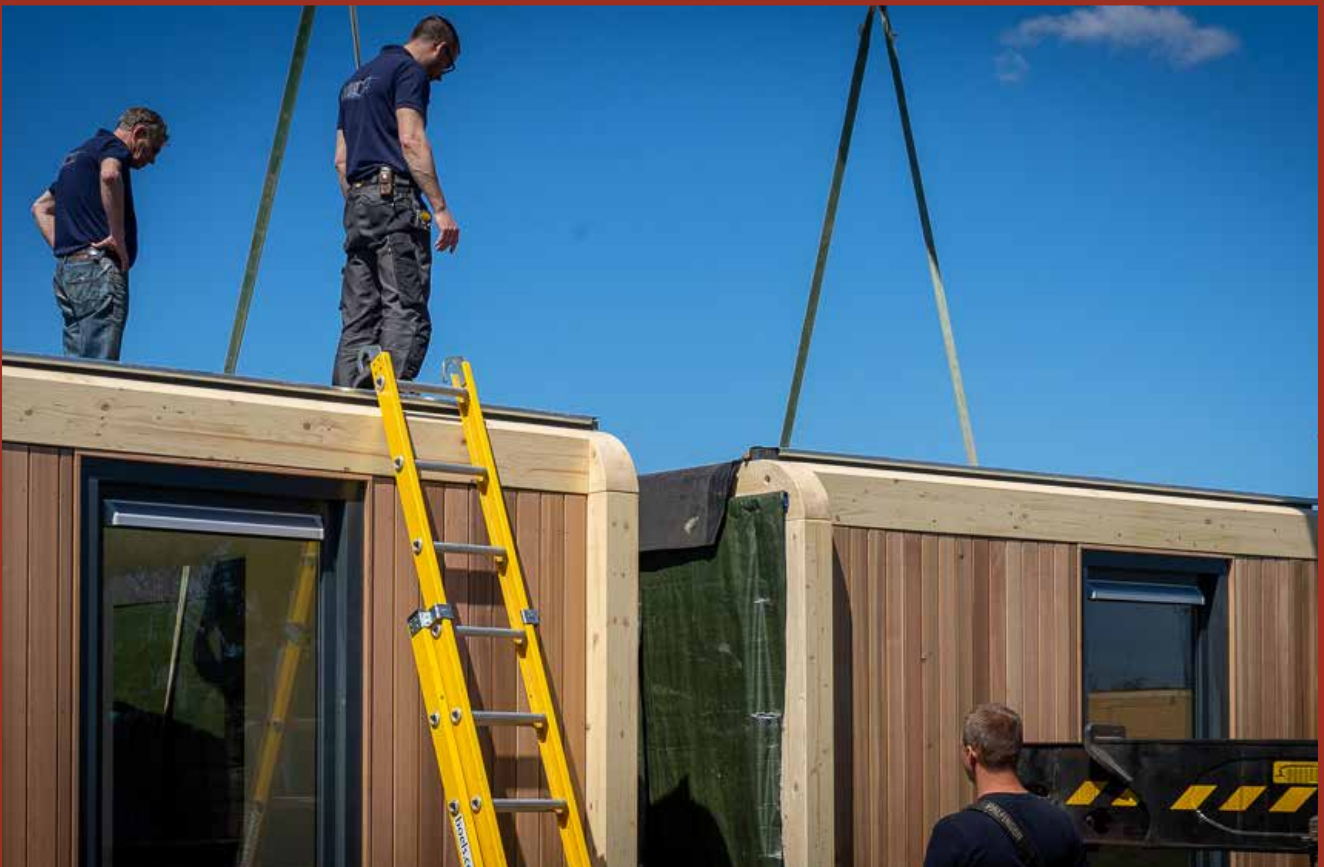
> Jos en Johan begeleiden het laatste stukje hijswerk.
