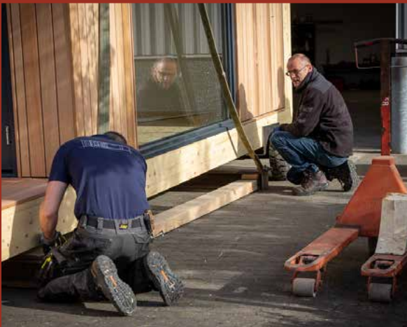
> Balken aanbrengen voor stabiel hijswerk.
