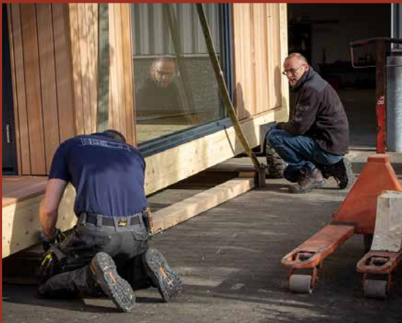
> Balken aanbrengen voor stabiel hijswerk.
