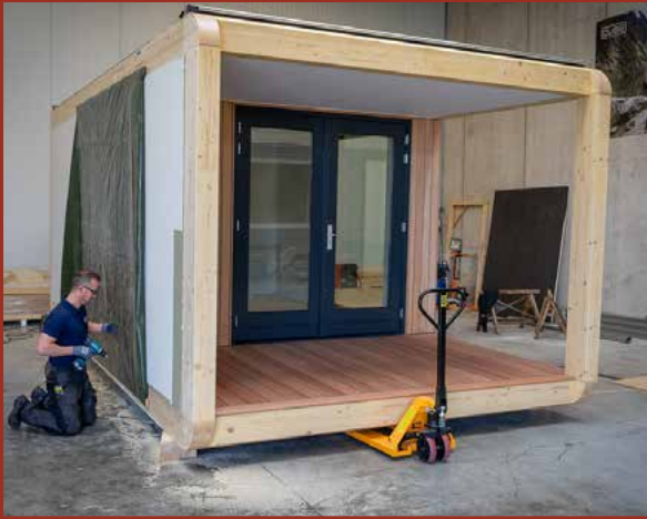
> Eerst folie aanbrengen aan de open zijdes.
