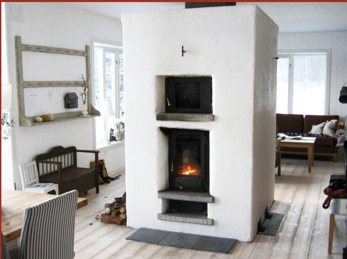
> Een rocket leemkachel van Vuur & Leem.
