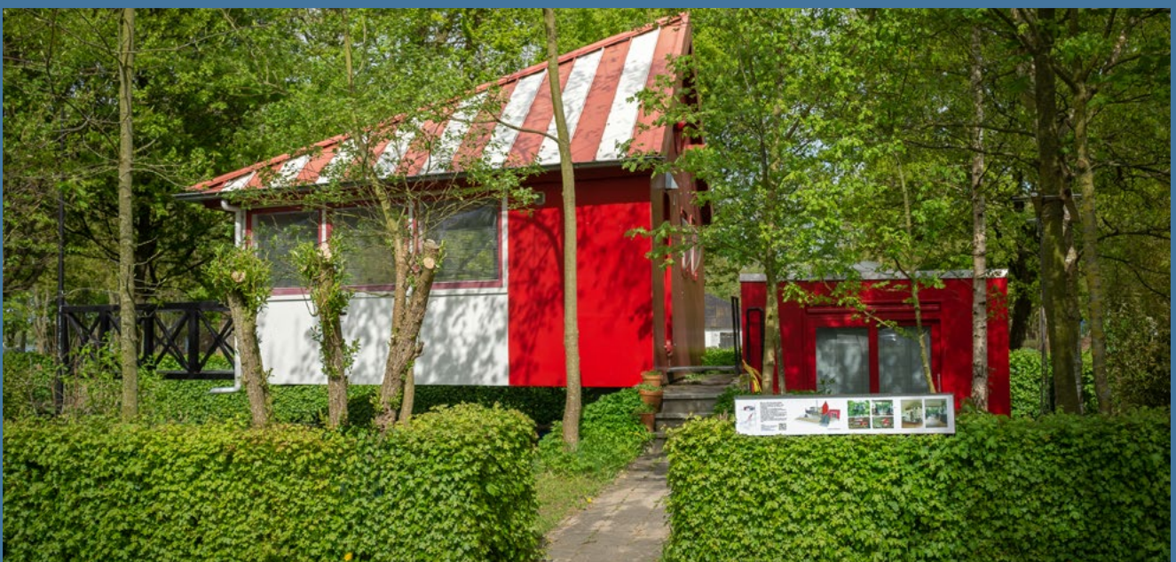
> Ibis is bedoeld als aanbouw, maar heeft alle kenmerken van een tiny house.
