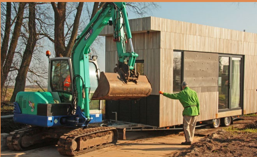
> Met een rupsgraafmachine wordt Elke's huisje voorzichtig verplaatst.
