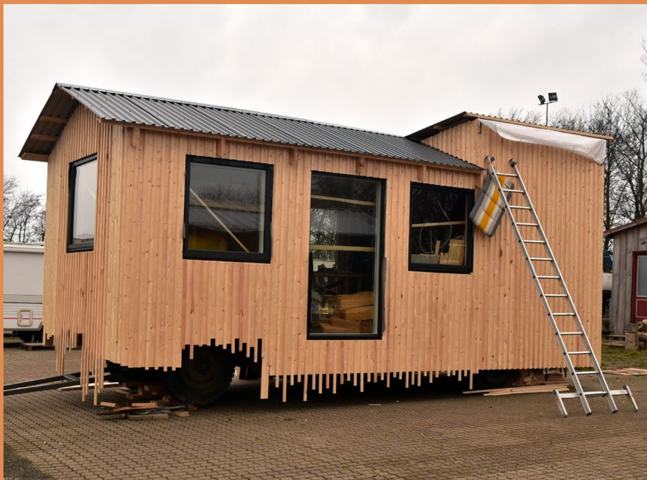
> Het tiny house van Marie en Peter in aanbouw.
